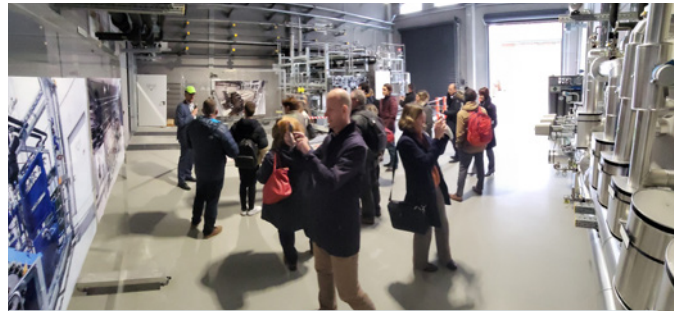
Innenansicht der Wasserstoff-Anlage am Wasserkraftwerk Grenzach-Wyhlen
