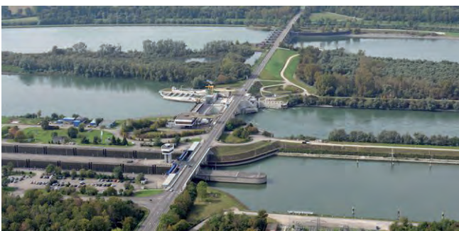
Wasserkraftwerk Iffezheim der Energie Baden-Württemberg EnBW (©EnBW)
