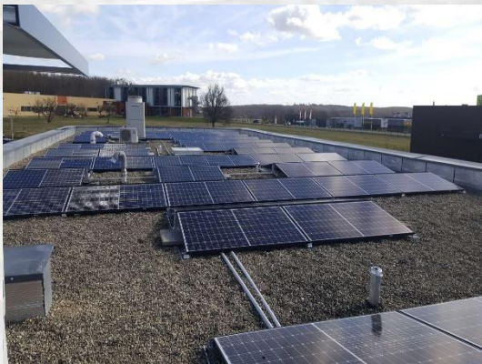
Ecole des Sources 36kWc, 180m 2 de PV
