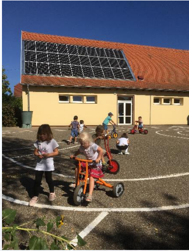
Ecole du Bouc d'Or à Saverne 9kWc, 55m 2 de panneaux
