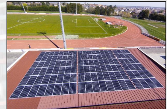
Club house Football Club de Saverne 36kWc, 200m 2 de PV
