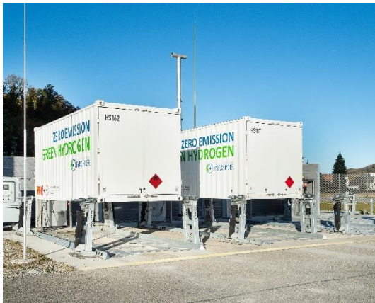
Speicherung in speziell entwickelten Containern
