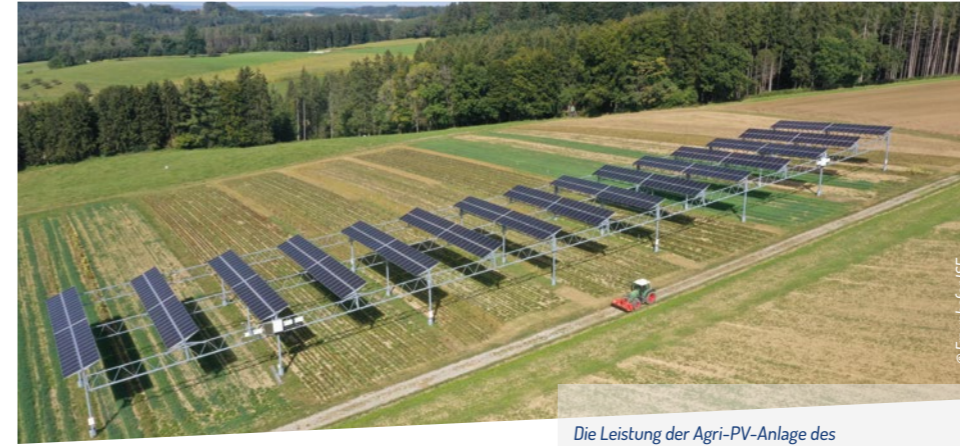
Die Leistung der Agri-PV-Anlage des Demeterhofs Heggelbach beträgt 194 kWp.
