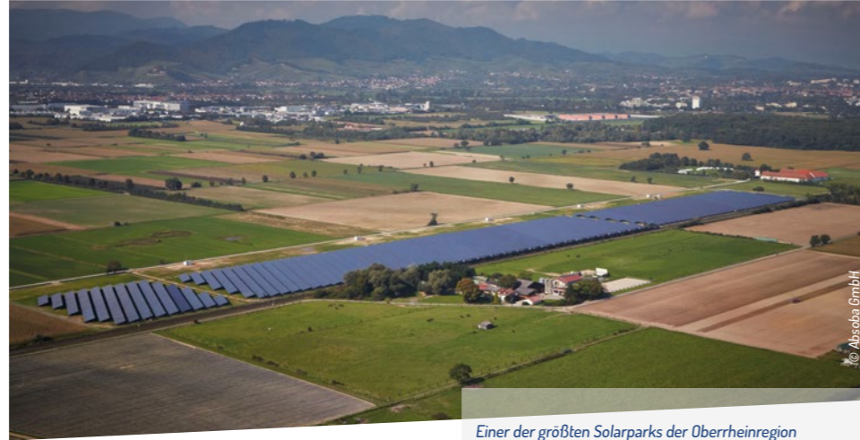
Einer der größten Solarparks der Oberrheinregion in Hohberg mit 39.000 Fotovoltaik-Modulen. Un des plus grands parcs solaires de la région du Rhin supérieur à Hohberg avec 39 000 modules photovoltaïques.
