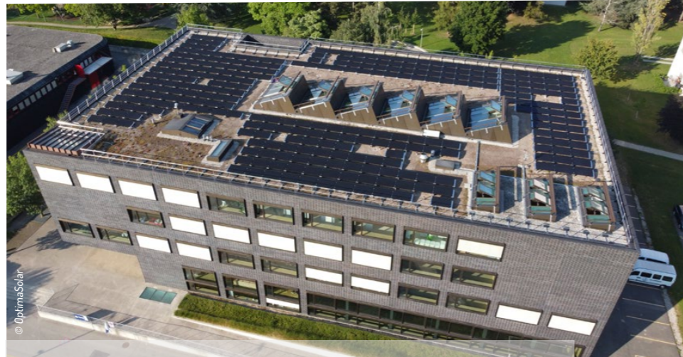
OptimaSolar hat in September 2021 diese PV-Solaranlage auf dem Dach eines Gymnasiums in Gland, in der Schweiz, in Betrieb genommen. Sie wird von Bürgern finanziert und verwaltet. OptimaSolar a mise en service en septembre 2021 cette installation solaire photovoltaïque sur le toit d'un collège de Gland, en Suisse. Elle est financée et gérée par des citoyens.
