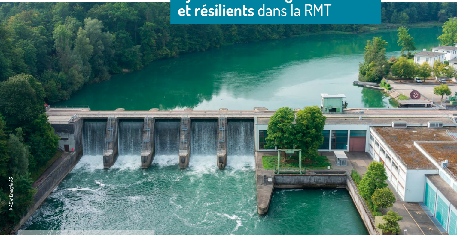
Wasserkraftwerk Bremgarten-Zufikon an der Reuss, installierte Leistung von 20 MW.
